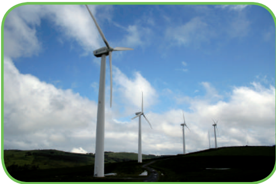
Campo energía eólica.
